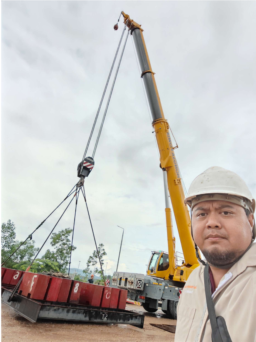
ทดสอบ Mobile Crane 160 Ton Hongsa Power สปป. ลาว
